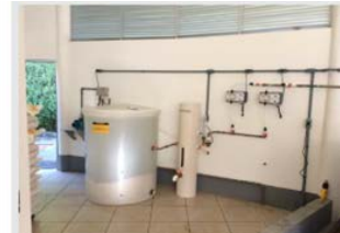
c) Dosagem a vácuo com válvula pilotada 4 - 20 mA
