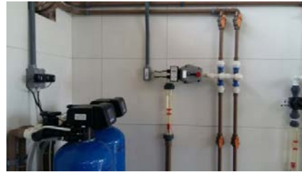
c) Dosagem a vácuo com válvula pilotada 4 - 20 mA
